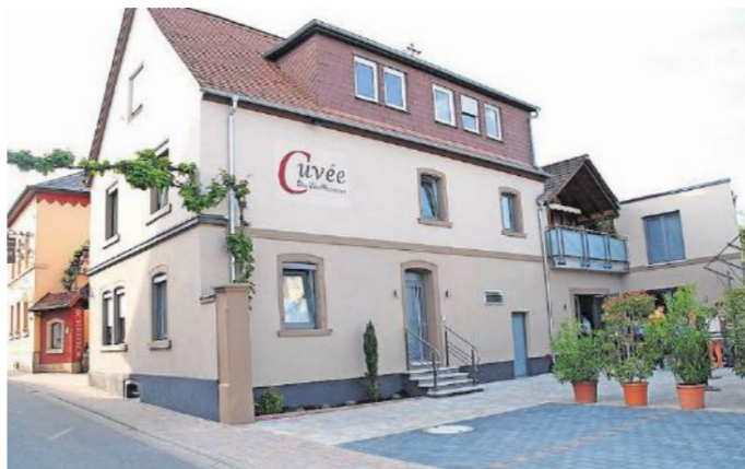
Gasliches Haus in der Hartmannstraße 36 in Maikammer.
